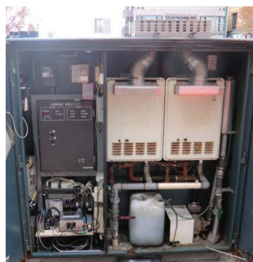
図2 既設ガス盤内部
