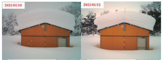
写真1 屋根積雪状況
