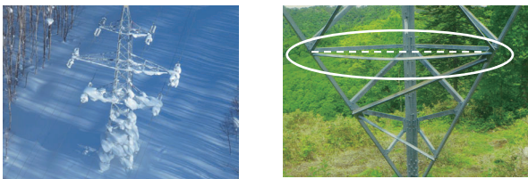
図 1 鉄塔の冠雪状況と部材変形の一例
