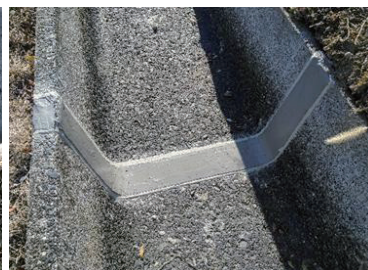
図-4：弾性モルタル塗布後
