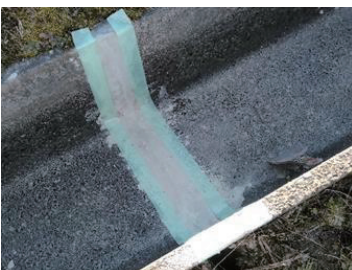
図-3：超速硬モルタル塗布後
