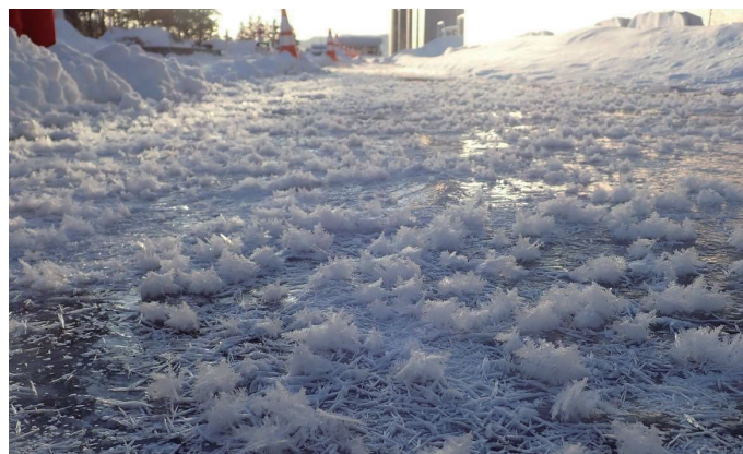
図1 ロードヒーティング舗装上の霜の花（2018年2月19日）
