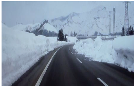
図1 中央分離帯で発生した雪堤崩れ
