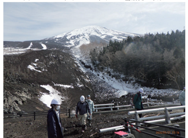
図3 石楠花橋付近のスラッシュ雪崩発生状況
